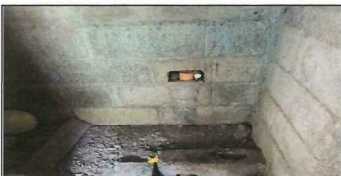
Foto 3: Se observa la necesidad de reparar el repello de los baños del establecimiento.
