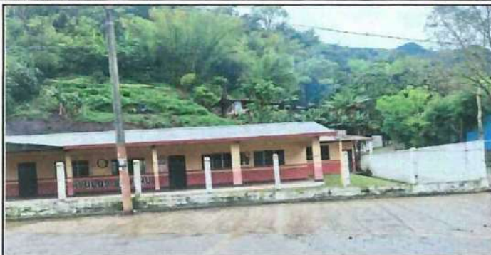
Foto 1: Se observa la necesidad de la reparacion del muro perimetral de block, para mayor seguridad del establecimiento.
